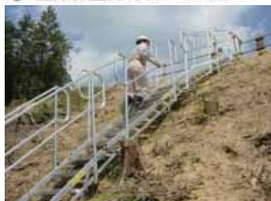
本技術は取付角度が自在に設定できるユニット式アルミ合金製階段です。従来は単管パイプにクランプ付きステップを一枚一枚取り付けて設置していましたが、本技術の活用により多様な傾斜角度でも常にステップは水平になり、昇降時の安全が確保されます。また、階段全体(手摺は着脱式)がユニットの為、従来の設置工数を大幅に削減できます。素材はアルミ合金製で軽量の為、足元の悪い斜面でも運搬・設置が容易に出来ます。本技術はNETIS平成24年度「推奨技術」【新技術活用システム検討会議(国土交通省)】に選定されました。
