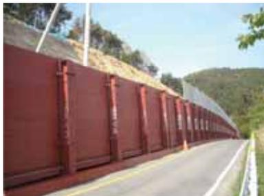
本技術は、鋼製のパネルを利用した落石防護柵です。従来は道路改良の法面工事や崩落災害の発生時に仮設の防護柵を設置する場合には、H鋼支柱に鋼矢板を溶接等で取り付けていましたが、「パネル式防護柵」では専用固定金具を利用してボルトで取り付ける方法としたため、仮設防護柵の設置・撤去の作業性を大幅に向上させることが出来ます。活用メリットとしては ①工期の短縮 ②パネルと支柱の連結性が高く落石の衝突エネルギーを吸収できる ③設置・撤去に特殊な技術を必要としない ④緊急災害発生時に材料の入手が容易である
