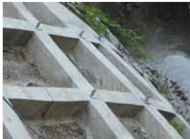
キャップナット・ロックボルトシステムは、腐食が最も懸念される頭部および頭部背面を亜鉛メッキ+飽和ポリエステルの二重防錆とした、耐久性の高いロックボルト工法です。
