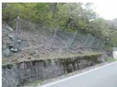
ARC (アーキ) フェンス S (スノー) タイプは積雪3.0mまでの雪圧および落石エネルギー50kJを受けても十分耐力を持つ経済性・施工性・安全性に優れた進化をとげた次世代の落石兼用雪崩予防工法です。軽量部材のため人力施工が可能であり、自穿孔アンカーで係留するため斜面掘削・樹木伐採がほとんどありません。またワイヤネット構造で有るため透過性に優れ周囲の景観を損ねません。従って環境保護のため森林伐採が困難、民家裏など用地確保が困難、落石発生が懸念される雪崩対策箇所に最適です。
