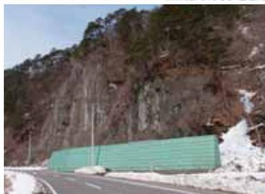
Geo BANK工法には、ロックジオバンク(RGB)工法、スノージオバンク(SGB)工法の分類がある。RGB工法は緩衝体に高密度ポリエチレン製樹脂の立体ハニカム構造のテラセル、中詰材に単粒度採石を用いることで最大4500KJの落石エネルギーに対応することができる。また、補強土体に多方向ジオグリットを併用することにより、落石衝撃荷重の分散効果が期待できる。SGB工法は、雪崩衝突面にプレキャストコンクリートパネルを採用した工法である。
