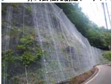
落石エネルギー吸収装置を設置した最大1,200kJまでの落石エネルギーに対応可能な、高エネルギー吸収型ポケット式落石防護網。
