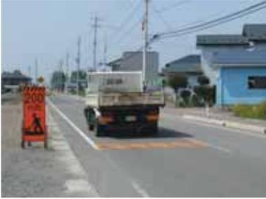
ピタリングは、通過する車両に対し「振動」と「音」を与え、注意喚起を促す工事保安用品です。現道工事現場でのセフティゾーン確保に力を発揮します。ピタリングの大きな特長は、【①道路面との粘着固定がなくても安定した使用が出来る】【②短時間での設置・撤去作業が出来、作業員の安全性が向上】【③これまで使用出来なかった「濡れ路面」の条件下でも使用が可能】ピタリングは、「現場の声」に耳を傾け今も尚、製品技術の向上に取り組んでいます。(ピタリングは「平成15年度、技術開発支援制度～(社)東北建設協会」による支援の下、開発された製品です)
