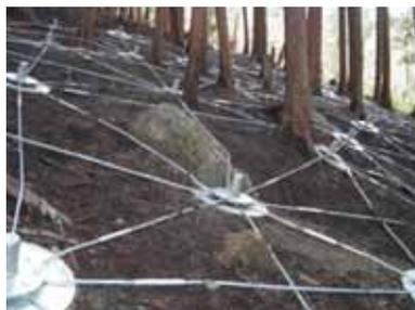
**初期崩壊防止型 地山補強工法 環境性能に優れ、ローコスト、生産性が向上し、工期短縮を実現**
