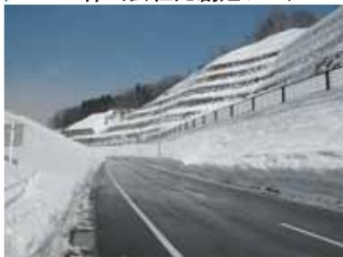
落石エネルギーE=250kJ程度、最大積雪深5m程度まで
