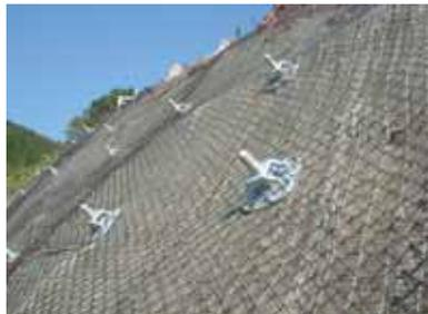
HDネット工法は、補強材による斜面全体の安定、HDネットによる中抜け土塊の崩落防止を目的とした新しい法面保護工法である。HDネット工法は、HDネット、補強材、HDプレート(上部、下部プレート)、ナットで構成される。補強材は下部プレートとナットで固定し、HDネットは上部プレートと下部プレートで挟み込み固定させる。HDネット工法はネットを確実に固定することができるため、凹凸が大きい場合を除き裏込め工は不要となる。
