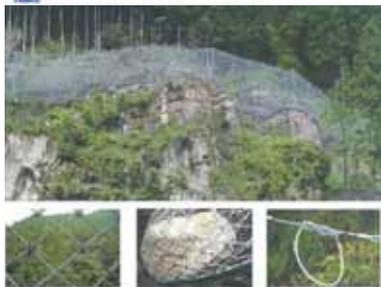
**補修が容易で維持管理コストを大幅に削減できる高エネルギー吸収型落石防止柵**
