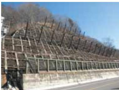
**積雪深6.0m、落石エネルギー400kJまで可能な高性能で環境負荷低減型の落石兼用雪崩予防柵です。**
