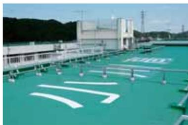
**防水層に直接貼付けが可能な高輝度再帰性反射ヘリサインフィルム**
