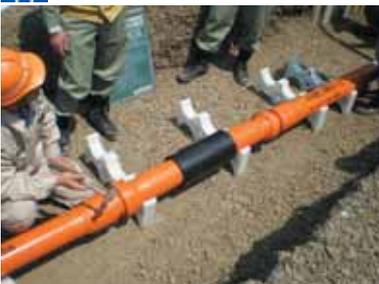
ケーブル保護管は、電力用ケーブルまたは通信ケーブルなどを収容、保護することを目的に設置されます。ケーブル保護管に耐震継手を組み込むことで、地震時における複合的な変位に追従可能となり、ケーブル保護管の機能を維持できるため、ケーブルの被害を防止します。
