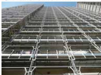
**手すり先行工法の新型安全装備、「アルミ製幅木付き先行手すり枠」**
