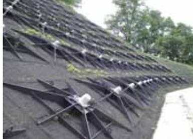
EHDアンカーは、JIS G 3536に規定されたPC鋼より線に耐食性が強いエポキシ樹脂を被覆し、グラウトとの付着向上の目的で表面に細粒けい砂を埋め込んだ付着型ECFストランドを引張材に用いたアンカーである。
